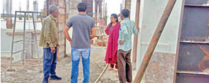
ఆసుపత్రి నిర్మాణ పనులను పరిశీలిస్తున్న సూపరిండెంట్ చం ద్రప్రియ
